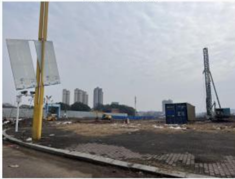
已建临时拦挡措施
